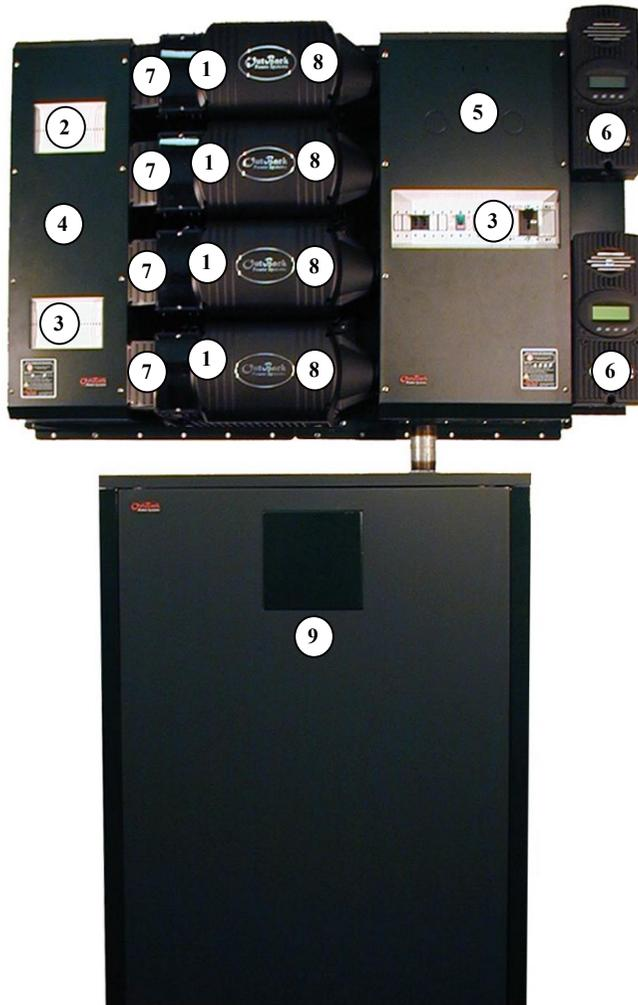
Situado debajo del panel del sistema QUAD, está una (PSR) - Outback Power System Armario que encierre y protege el sistema de baterías.
